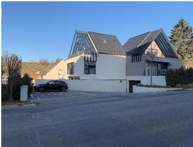
Abbildung 16: Fehlende Randabschlüsse, Belagsflicke
