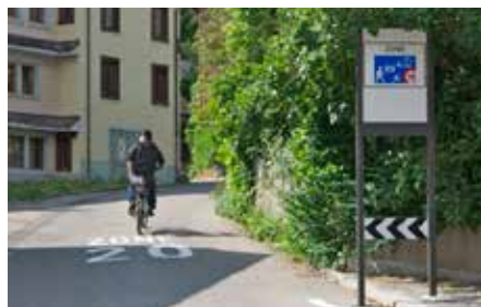
Gestaltung des Zoneneingangs mit Torwirkung – Tore am Eingang.
