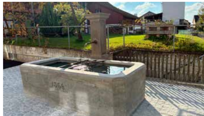
Totalsanierung inklusive Brunnenplatz vom «Bollenbrunnen» aus dem Jahr 1866. (Fotos: Martin Käser)
