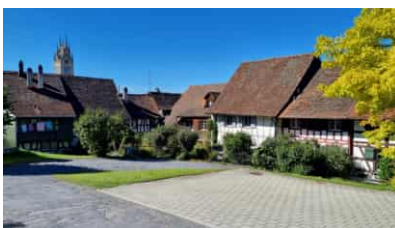
Freiraum westlich des Friedhofs
