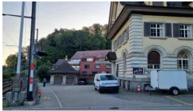
U-Zo IV Gemischte Bebauung aus Bauernhäusern, Wohn- und Gewerbebauten entlang Landstrasse (Erhaltungsziel b)
