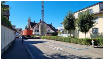
Wohnhaus Thurtalstrasse 21 rechts
